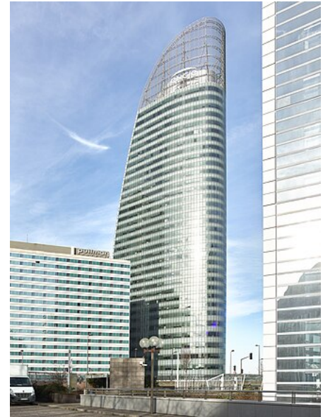
Engie headquarters in La Défense , Courbevoie, France
